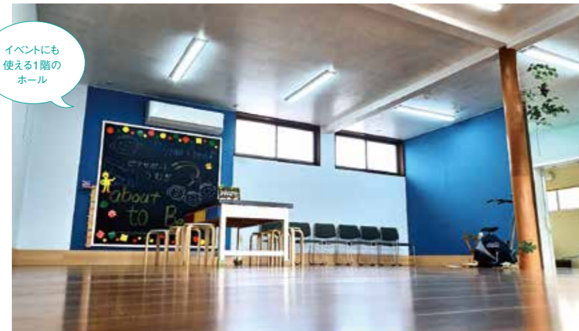
当初、床や壁ははがれた状態だったが、多くのボランティアの協力を得て、DIYで見違えるように明るい空間に生まれ変わった
