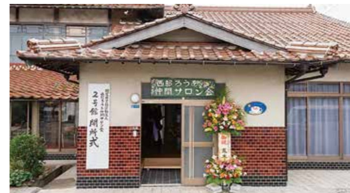
今回の事業で整備された新拠点。「まちの保健室」もここで開催されている
