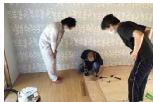
床張り作業の様子をしっかりと見学する参加者たち。この後、自らの手で丁寧に床板を張っていった
